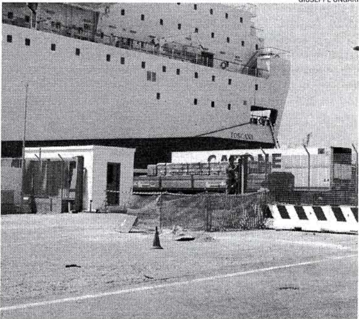
Le nuove strutture nel porto
