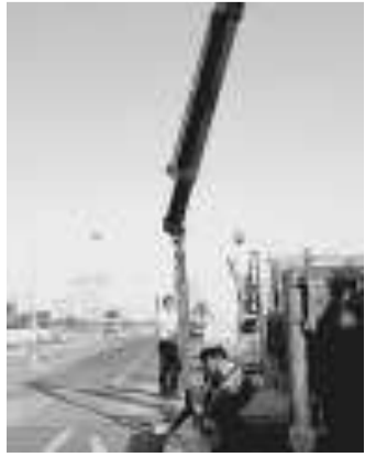
I lavori al porto di Cagliari
